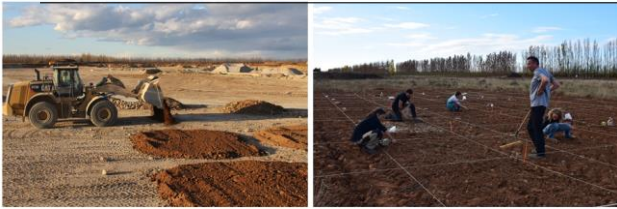
Figure 2 – A gauche : restauration de substrats constitués de différents mélanges de terre et de matériaux bruts [8] ; A droite : semis d'un mélange de graines, transfert de foin ou de graines récoltées par les fourmis (étude en cours) (crédits photos J. Chenot-Lescure et L. Saby, IMBE).
