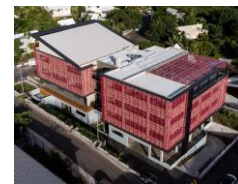
Figure 2 – Vue extérieure site d'installation du nanoréseau CC
